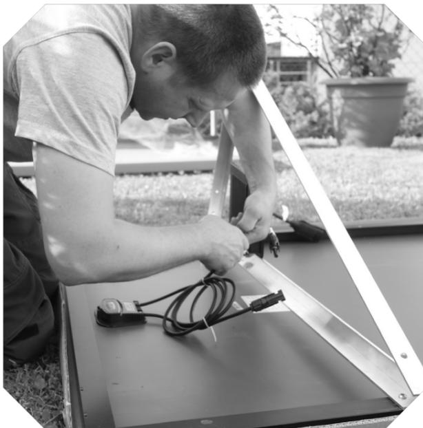
Befestigen Sie anschließend die unteren Halterungen am Modul: Je nach System können das Winkelbleche oder Schienen sein, die am unteren Rahmen verschraubt werden.
