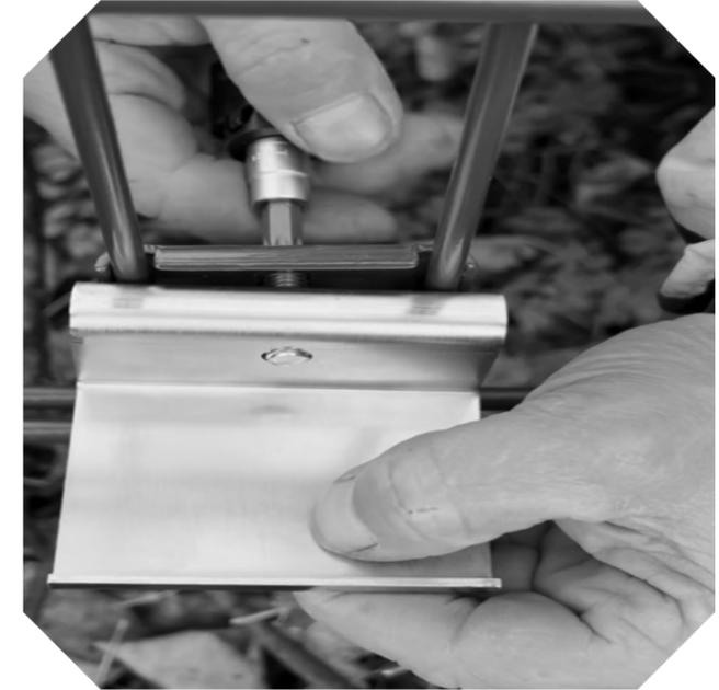
Gebrauchte Solarpanels können nachträglich an Zäunen angebracht werden. Es gibt Zaunhalterungen auch für die alten 50 mm Alurahmen. Diese einfach unten einspannen, Panel einlegen und oben befestigen. (Bild oben)
