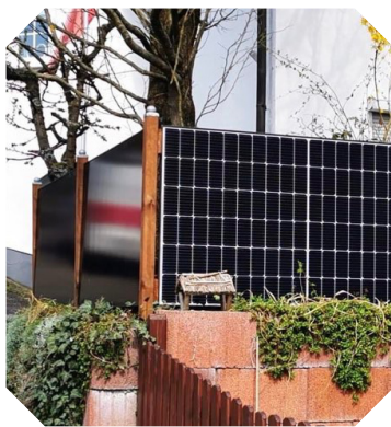
Historisches Gebäude mit Steckersolarzaun in Kombination mit Dachsolaranlage. Foto: Sebastian Müller
