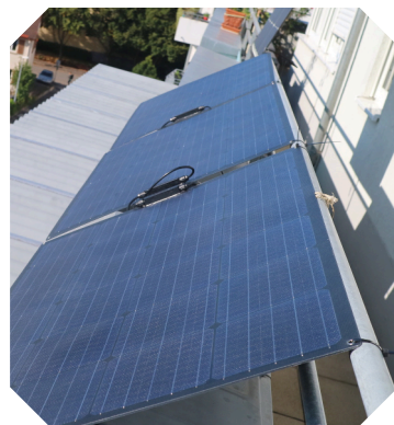
Leichtmodul mit Kabelbindern befestigt. Foto: Sebastian Müller
