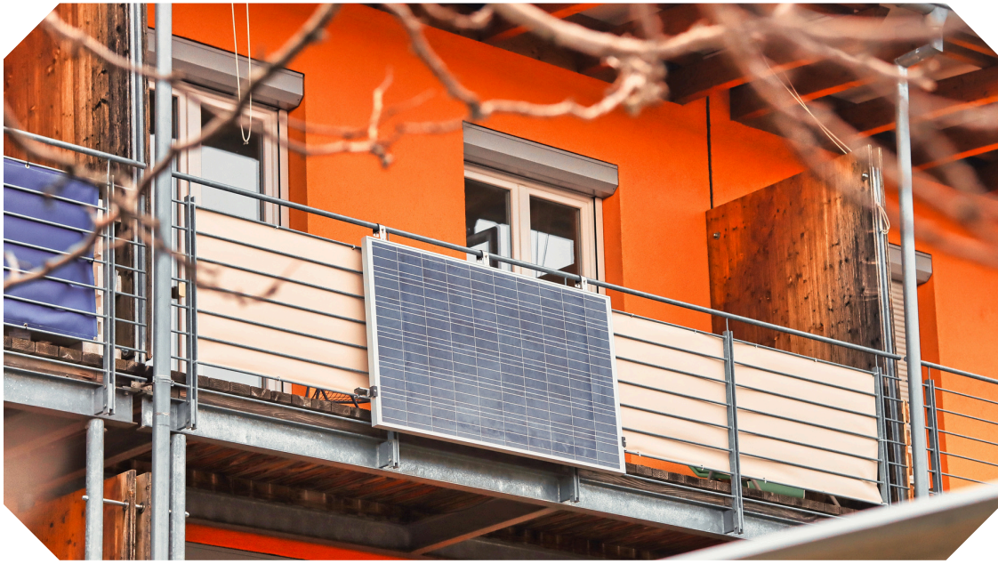
Häuser in Freiburg Haslach mit Balkonsolargeräten am Balkon. Bild: Sebastian Müller
