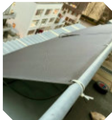
Leichtmodul mit Kabelbindern befestigt. Foto: Sebastian Müller
